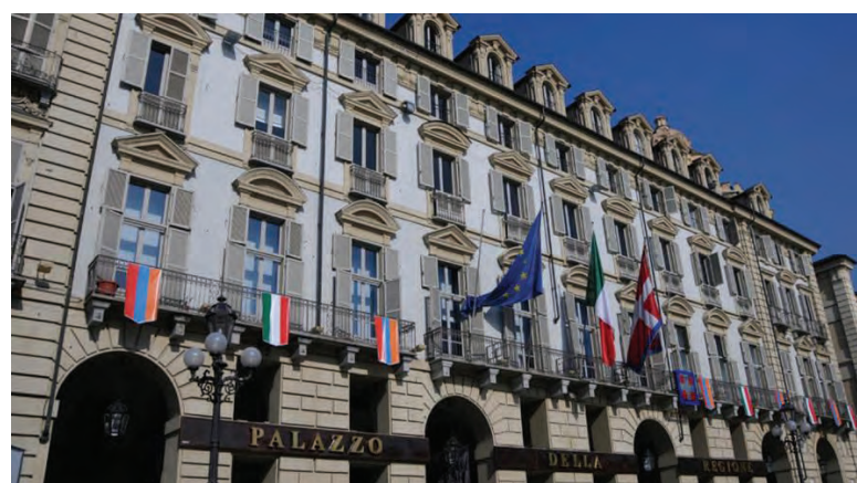
Il palazzo della Giunta regionale del Piemonte, in piazza Castello a Torino
