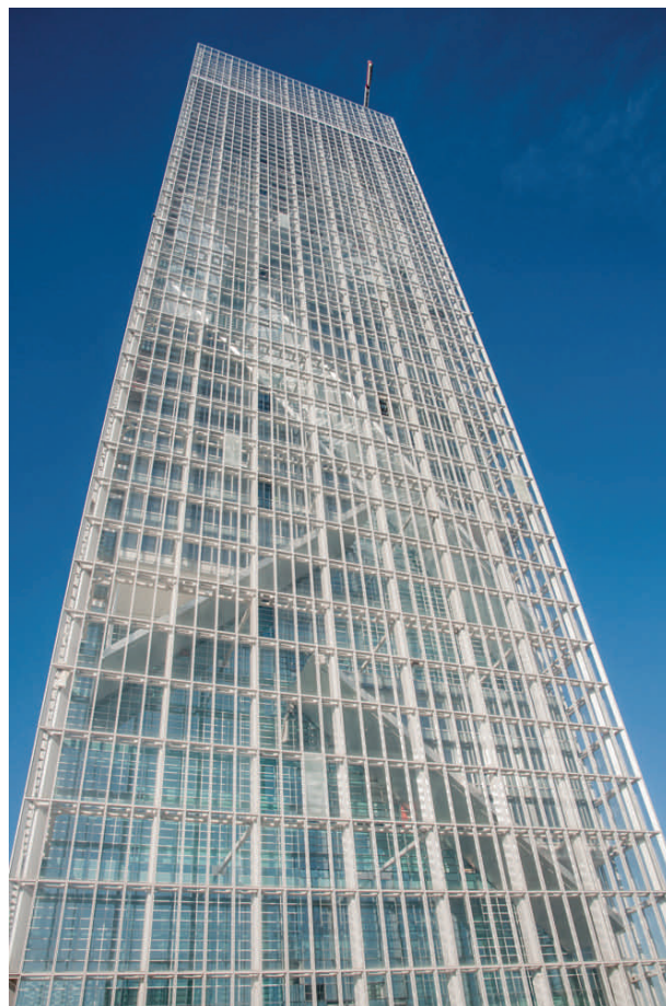
Giovedì 8 giugno presentato il completamento dei lavori al grattacielo della Regione Piemonte presentato
