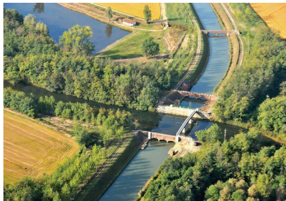
Il Canale Cavour sottopassa il torrente Agogna attraversando le tombe sifone (gallerie subacquee). A destra, scavalca la Dora Baltea passando su un ponte canale (foto Cabiati)
