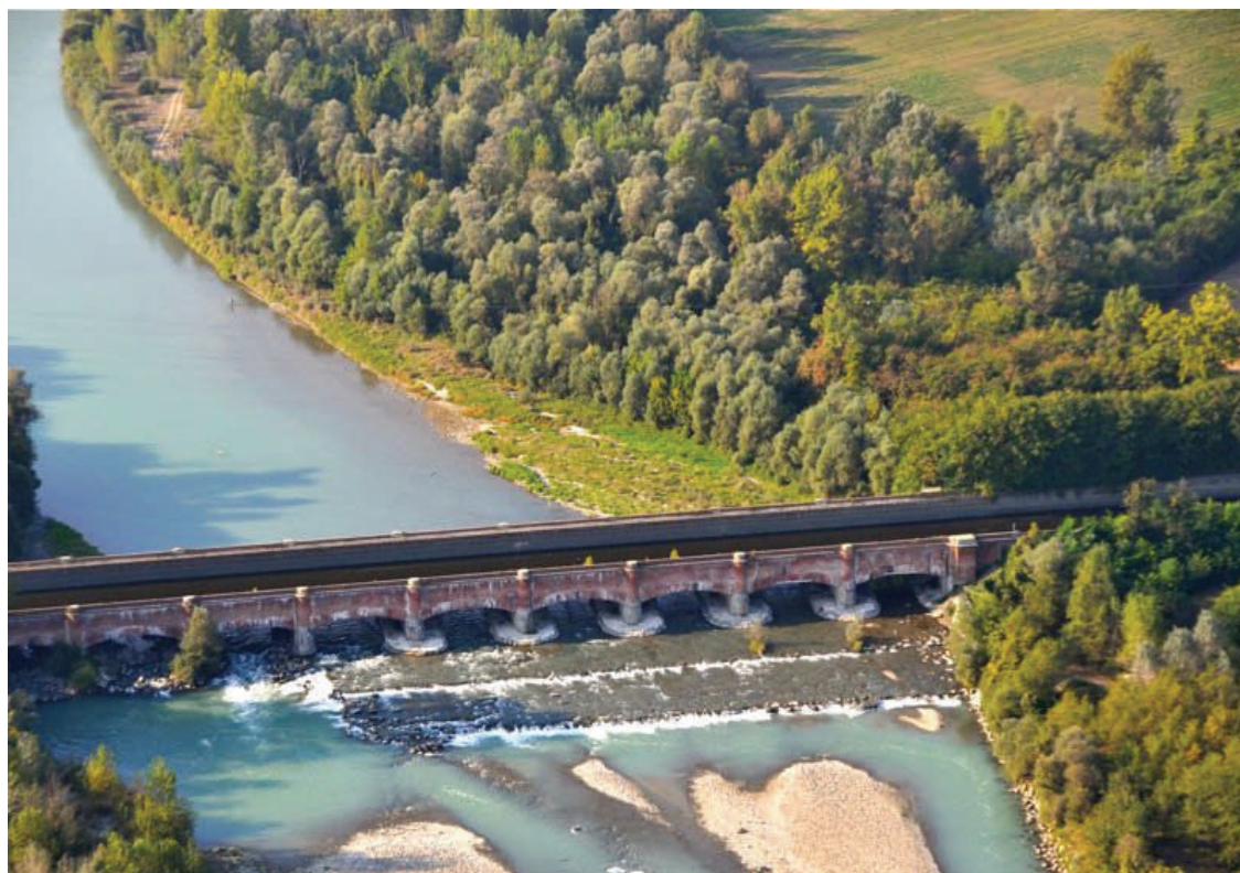
Il Canale Cavour sottopassa il torrente Agogna attraversando le tombe sifone (gallerie subacquee). A destra, scavalca la Dora Baltea passando su un ponte canale (foto Cabiati)
